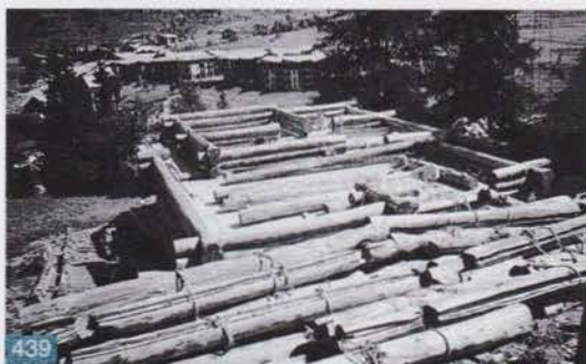
Remontage des premiers tours : en zone de montagne, il n'y a pas toujours beaucoup de place pour ranger les bois.
