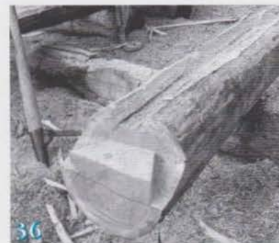
Queue-d'aronde utilisée pour un aboutage sur un mur.
