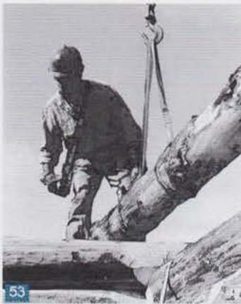
53 Le fustier travaille seul, un œil sur le fût, un doigt sur la commande de la grue
