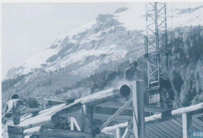
La faitière va être mise en place, tandis que le plafond est posé en partie basse du toit.
