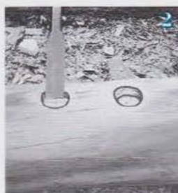
435 Réservations pour prises découpées à la scie cloche et finies au ciseau
