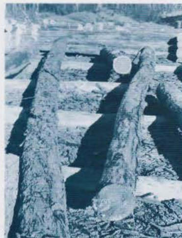
Ces bois tordus, rappel de l'arbre et de la nature, signature du constructeur. Mais évitez qu'ils ne viennent déformer un mur.
