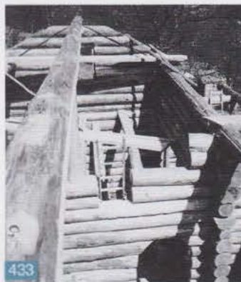
Les rainures des pannes, pignons et solives pour encastrer les plafonds sont découpées au démontage
