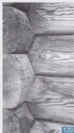
120 Têtes de bœuf en Norvège sur rondins rendus ovales, une technique très ancienne
