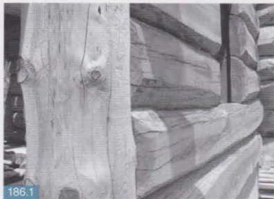
Rondins équarris sur une construction contemporaine.
