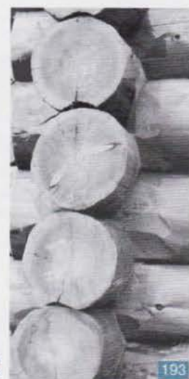
... ou quand on n'a pas laissé de jeu entre les débords (comparez bois du haut et du milieu)
