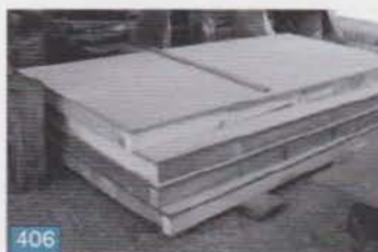
L'aire de traçage : plusieurs caissons à ossature-bois de 2,50 m x 1,25 m qui seront calés et assemblés.
