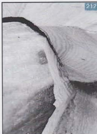
Bois sous-tracé avant compression (sous-tracage des côtés de la gueule) : un jeu important apparaît au sommet de la gueule
