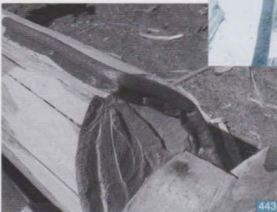
Joint P. Gasket agrafé (doc. Logworks.ca, voir Carnet d'adresses)
