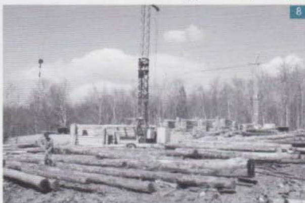
Un chantier de construction de fustes équipé de deux grues distributrices. Ecorçage des fûts au premier plan.
