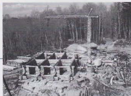
Dans une grue à montage rapide, la rotation se fait à la base: le mât et la flèche tournent ensemble. C'est la grue idéale pour le fustier.
