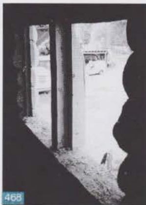
Feuillure intérieure découpée dans le linçoir pour recevoir la menuiserie.
