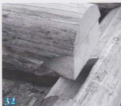
Le jeu doit être minime.
