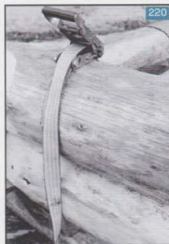
Sangle à cliquet (résistance 5 t.) pour précompresser les bois
