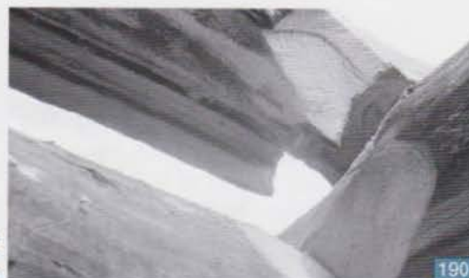
Les arêtes de la gorge : un assemblage bois sur bois
