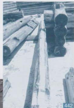
Le fût entaillé, rempli d'isolant, est prêt à être posé
