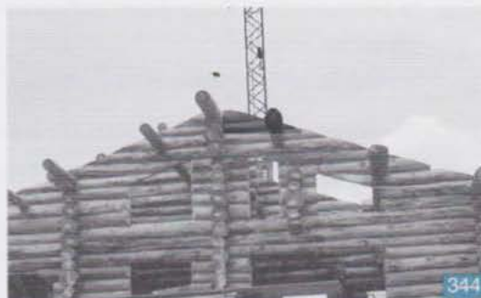
Profondeur d'encastrement des pannes
