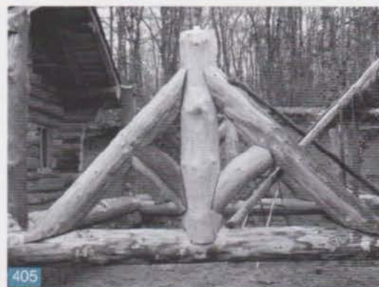
Ferme à poinçon et contrefiches. Les pièces ne sont soumises qu'à des efforts de compression ou traction. Entre le poinçon et l'entrait, un jeu de quelques cm
