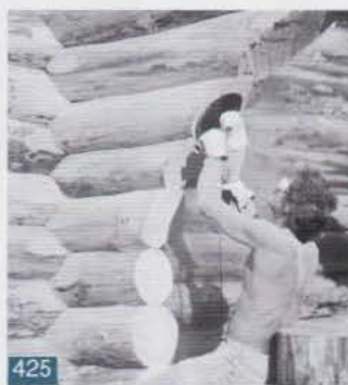
Le ponçage des arches
