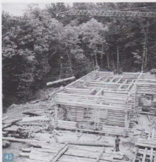
Implanter la grue pour bien desservir tout le chantier
