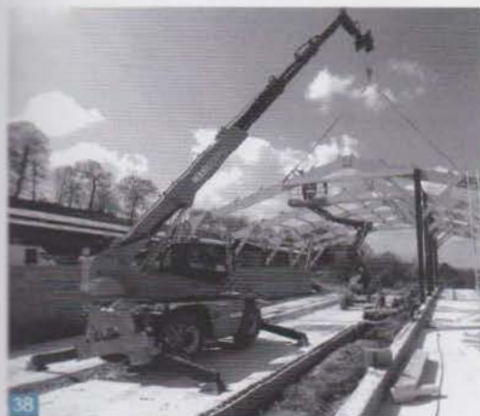
Le chariot télescopique rotatif peut être aussi radiocommandé : une solution pour les montages (document Manitou)
