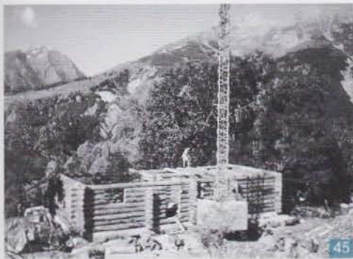
En haute montagne, sans électricité, grue commandée par un moteur Bernard à essence
