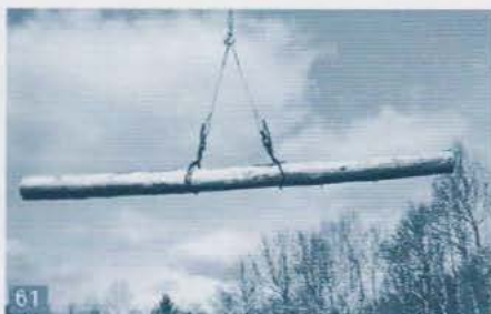
61 Les crochets ne doivent pas être trop écartés
