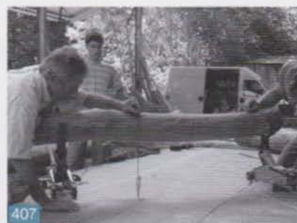
Chaque pièce est présentée sur l'aire de traçage avant épure définitive.
