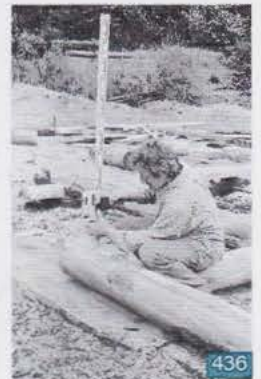
436 Au dernier tour du démontage, prendre scrupuleusement les niveaux et les diagonales
