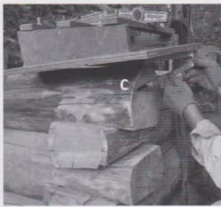
Traçage sur le bois inférieur
