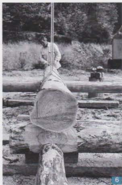
... pour donner au fût sa bonne place et sa bonne position. C'est tout l'art de la fuste.
