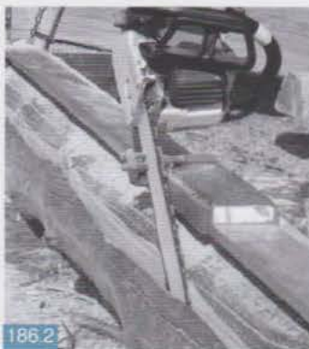
Scier en s'aidant d'un guide en U
