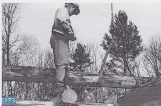
273 Bien regarder le fût pour déceler les courbures, et le mettre en bonne position, seul et aisément, grâce à la radiocommande de la grue.
