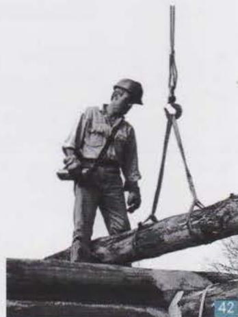
Avec la radiocommande, le fustier peut travailler seul avec précision et sécurité
