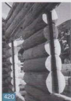
Feuillure d'encastrement, linteau et seuil (ou tablette) d'une porte et d'une fenêtre
