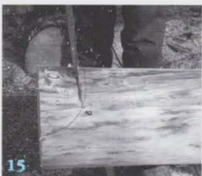
Couper la partie inférieure de l'entaille.
