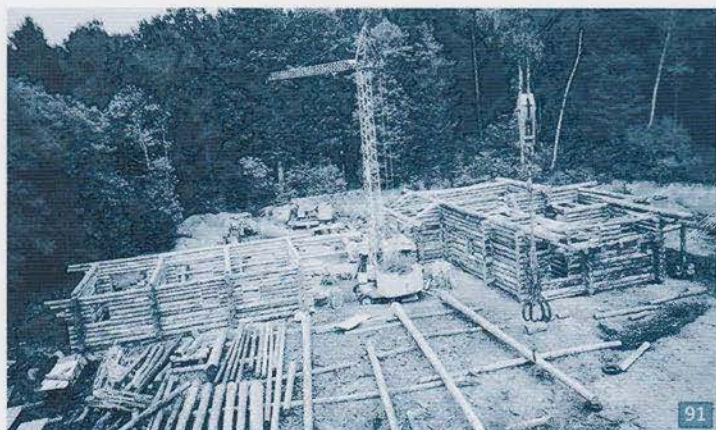
Une grue dessert les deux ossatures, la zone de découpe (à l'arrière) et le stock de bois triés et écorcés
