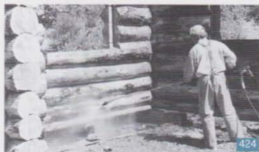
Le nettoyage à l'eau sous pression au « Kärcher »
