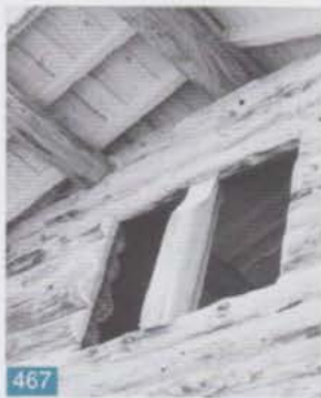
Le bas du poteau-linçoir peut être de diamètre supérieur et venir en légère saillie par rapport à l'appui du tableau
