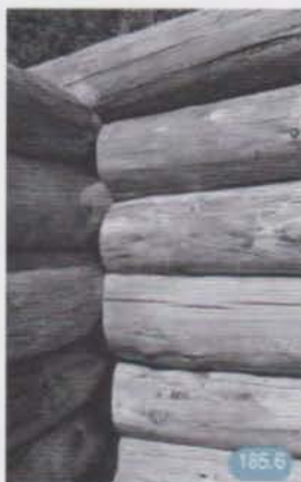
L'aspect intérieur des rondins restera naturel aussi bien pour la dent de mouton que la dent de loup.
