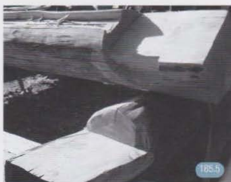
Queue d'aronde à recouvrement et épaulement en dent de mouton.
